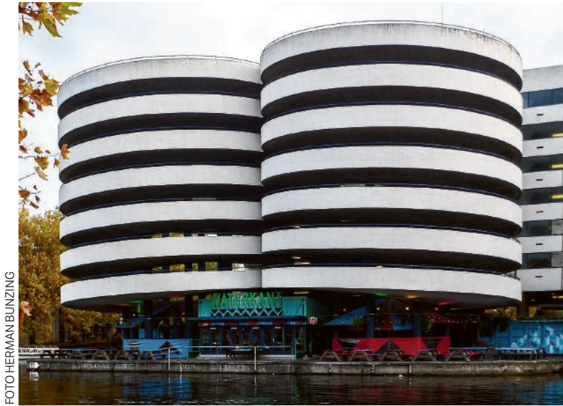
Parkeergarage Marnixstraat, Piet Zanstra.
